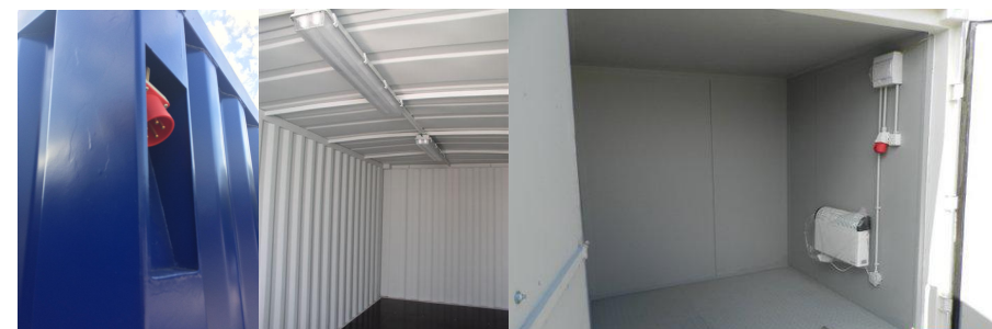
Installation électrique : luminaires LED, convecteurs, prises de courant ...
